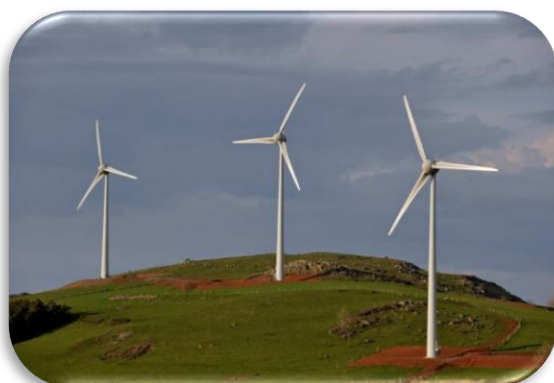
Parc éolien de Saulzet de 14,4 MW situé en Auvergne et mis en service en 2009
